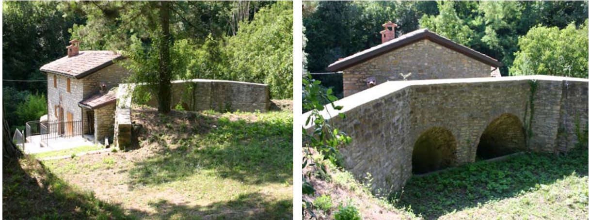
Mulino Valletto. L'edificio ristrutturato con il particolare della botte e delle due trombe ben conservate
